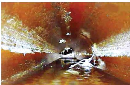
Fettablagerungen in den Abwasserkanälen. Deutlich sichtbar die „goldene“ Schicht der Fette und Öle
